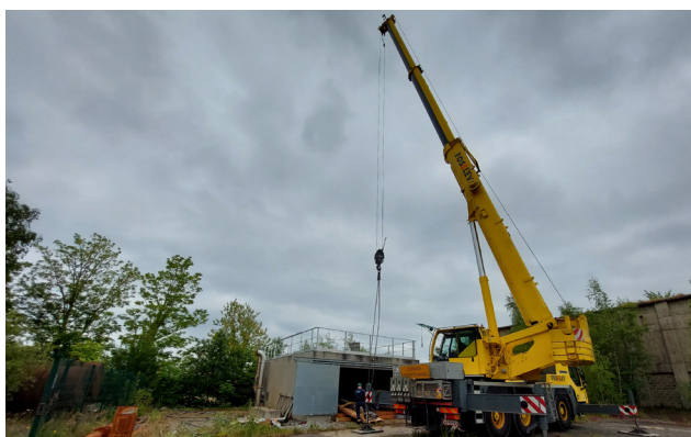
Intervention sur la colonne d'exhaure
