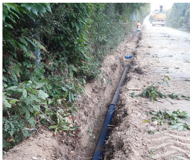
Travaux du feeder de Bécon-les-Granits - Villemoisin.
