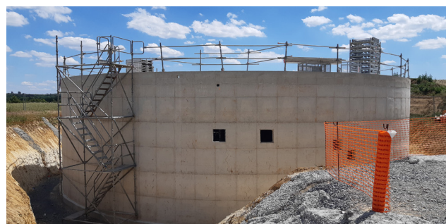
Travaux du réservoir de Seiches-sur-le-Loir.
