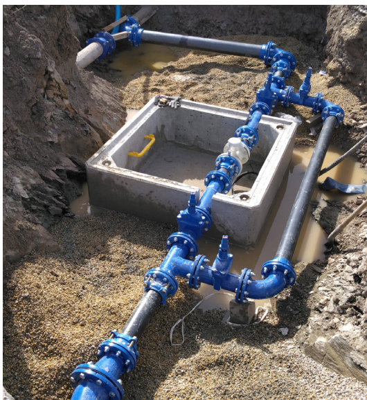
Installation d'un compteur de sectorisation.
