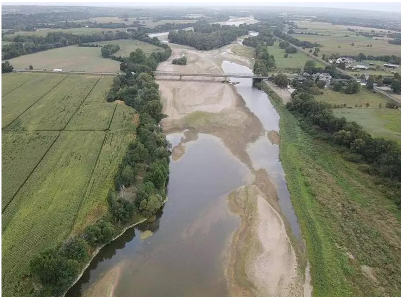
La Loire à hauteur du pont du Grand Bras entre Chalonnes-sur-Loire et Saint-Georges-sur-Loire, le 5 septembre 2023.
